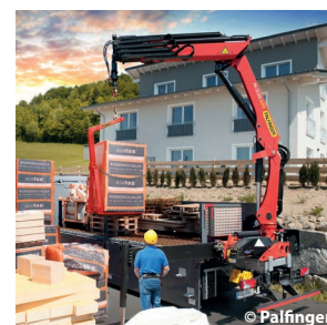
Richtig: Kranführer mit Fernsteuerung außerhalb des Gefahrenbereiches
