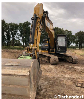
Die DGUV erklärt, Baggerfahrer sind gründlich auszubilden.
